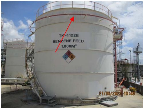
รูปที่ 3.2-74 ระบบ Water Spray ที่ถังเก็บสารเคมี
