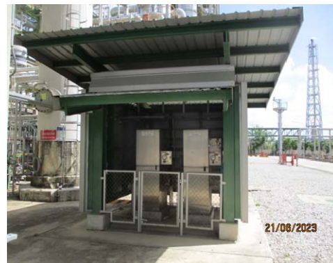
รูปที่ 3.2-6 เครื่องตรวจวัดเบนซินแบบต่อเนื่อง ที่ปล่อง Charcoal Adsorber 2
