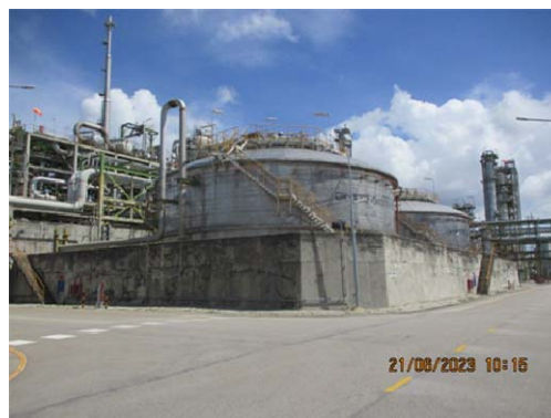
รูปที่ 3.2-67 คันคอนกรีตบริเวณที่เก็บกักวัตถุดิบ และผลิตภัณฑ์
