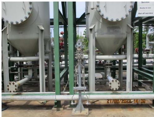
รูปที่ 3.2-9 เครื่องตรวจวัดความดันที่ทางเข้า-ออก ของ Charcoal Adsorber
