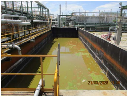
รูปที่ 3.2-29 บ่อพักน้ำทิ้งฉุกเฉิน (Diversion Basin : TK-9142A/B)
