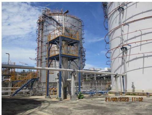
รูปที่ 3.2-11 ระบบดักจับไอระเหยด้วยน้ำ (Acetone Wet Scrubber) ของถังเก็บสารอะซิโตน (TK-4163A/B)
