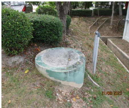
รูปที่ 3.2-37 บ่อตรวจสอบคุณภาพน้ำทิ้ง จากสำนักงานและโรงอาหาร
