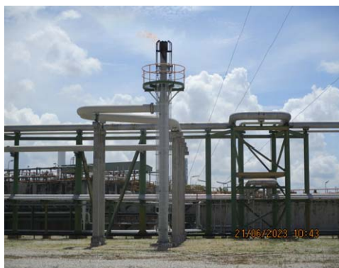
รูปที่ 3.2-7 หอเผาแบบความดันต่ำ (Low Pressure Flare)
