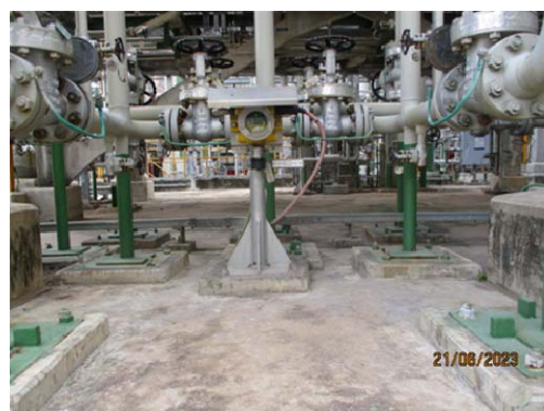
รูปที่ 3.2-14 Gas Detector
