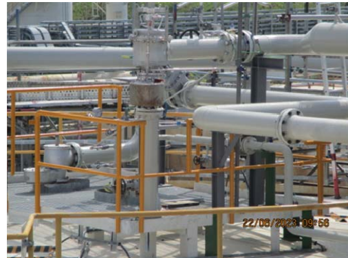
รูปที่ 3.2-61 วาล์วนิรภัยที่ถังเก็บก๊าซสารเคมี
