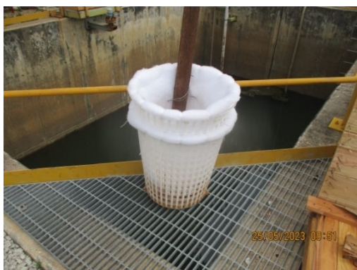
รูปที่ 3.1-9 ตะแกรงดักขยะบนรางระบายน้ำฝน
