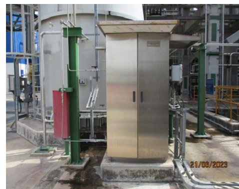
รูปที่ 3.2-8 เครื่องตรวจวัดสารประกอบ ไฮโดรคาร์บอนแบบต่อเนื่อง ที่ปล่อง Charcoal Adsorber 6
