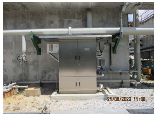
รูปที่ 3.2-32 เครื่องตรวจวัด COD แบบอัตโนมัติ ที่ Final Polishing Buffer Tank (TK-9145)
