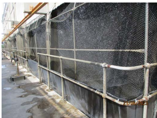
รูปที่ 3.2-19 แผ่นกันเสียงที่ห่อหุ้มเครื่อง
