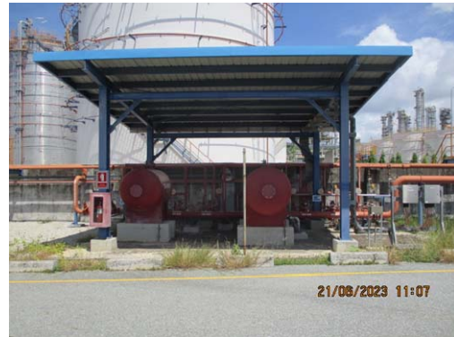
รูปที่ 3.2-75 ระบบดับเพลิงบริเวณถังเก็บกักอะซิโตน
