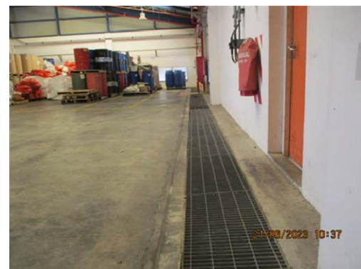
รูปที่ 3.2-54 รางระบายน้ำในอาคารเก็บของเสีย
