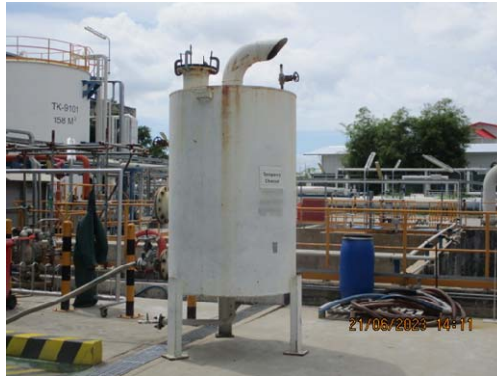
ปล่อง Charcoal Adsorber แบบเคลื่อนที่ รูปที่ 3.2-4 ปล่องระบายอากาศของโครงการ (ต่อ)
