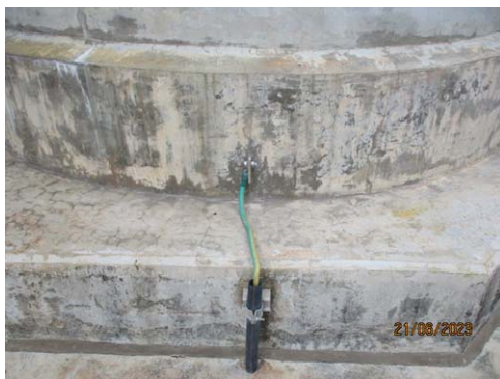
รูปที่ 3.2-62 ระบบสายดินที่ถังเก็บก๊าซสารเคมี
