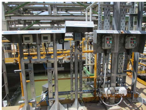
รูปที่ 3.2-31 เครื่องตรวจวัดคุณภาพน้ำทิ้ง แบบอัตโนมัติ ที่บ่อพักน้ำทิ้ง (Final Polishing Pond : TK-9141)
