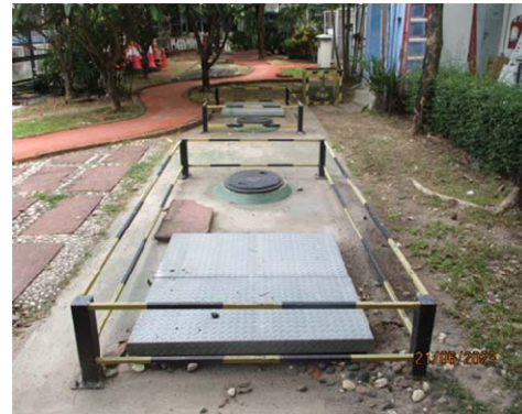
รูปที่ 3.2-36 ระบบบำบัดน้ำเสียแบบไร้อากาศ และเติมอากาศแบบสำเร็จรูป
