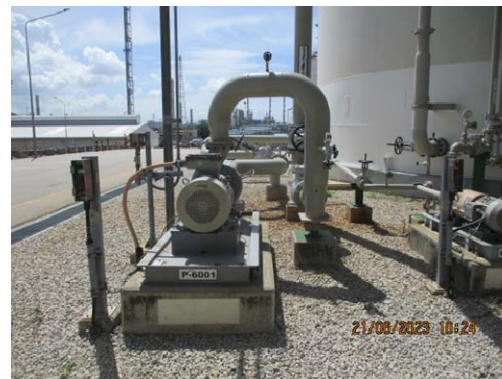
รูปที่ 3.2-12 เครื่องสูบน้ำสำรอง สำหรับระบบน้ำที่จ่ายน้ำให้ Scrubber
